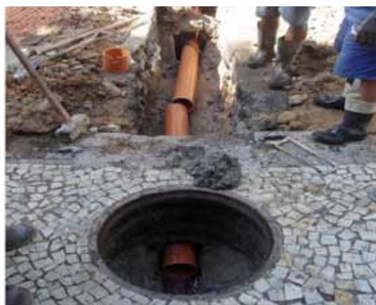
Substituição de ligação predial devido a problema de incrustação de gordura
