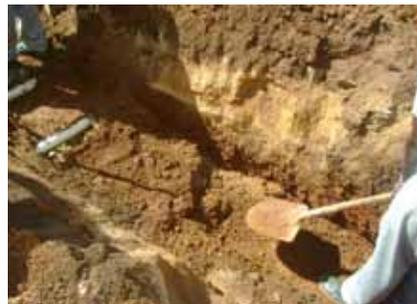
A escavação mecânica é mais difícil de controlar e, às vezes, pode provocar a quebra ou destruição das outras redes interferentes. Os equipamentos mais utilizados são: retroescavadeiras, escavadeiras hidráulicas, *drag-lines* (para raspagem em terrenos pouco consistentes e de difícil acesso), pás-carregadeiras (para carga de material solto dos caminhões).
