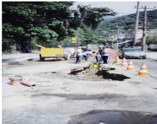
Colapso do pavimento por vazamento da tubulação
